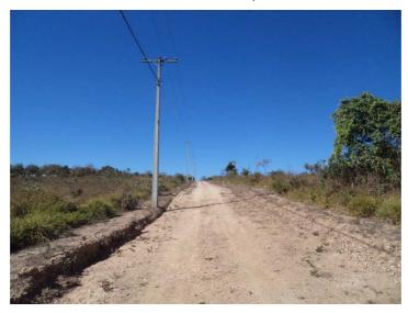
Figura 113: Aspecto da via interna em solo exposto e com pouco cascalho. Trecho em declive
